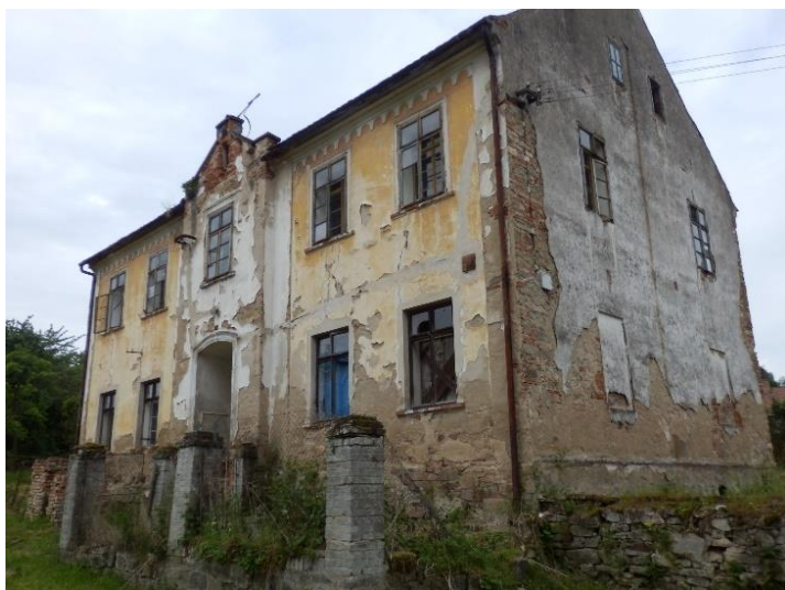
Budova fary před rekonstrukcí
