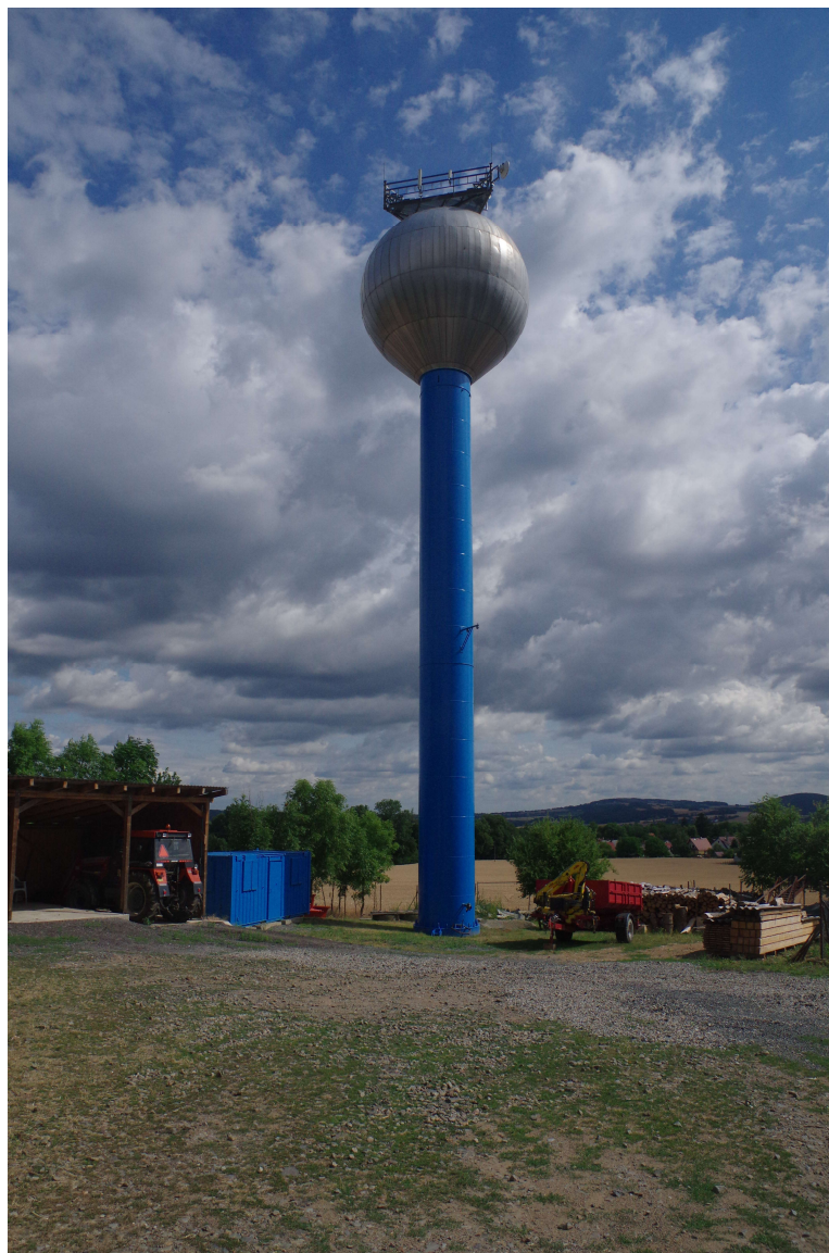
vodojem AKNAGLOBUS s kapacitou 200 m 3
