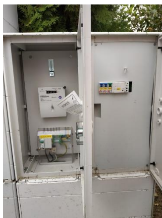
Obr.8 RVO Hrad – celkový pohled a detail elektroměru
