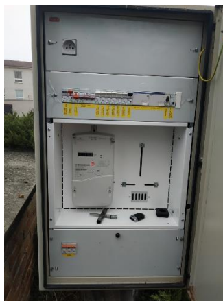
Obr.5 RVO Albrechtice nad Vltavou – celkový pohled a detail elektroměru
