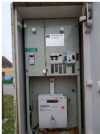
Obr.7 RVO Újezd – celkový pohled a detail elektroměru
