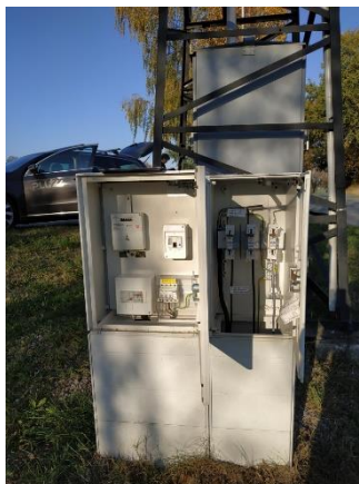
Obr.8 RVO Hněvanice – celkový pohled a detail elektroměru
