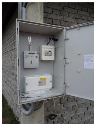
Obr.7 RVO Štědrónín - detail elektroměru
