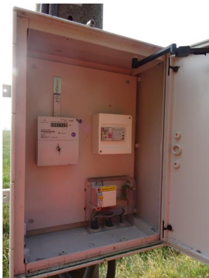
Obr.5 RVO Zbonín - detail elektroměru
