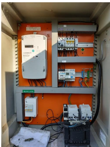
Obr.2 RVO celkový pohled a detail elektroměru
