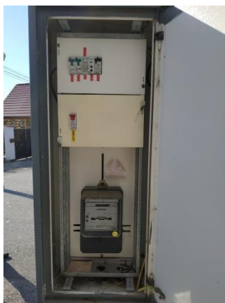
Obr.4 RVO Zbislav – celkový pohled a detail elektroměru
