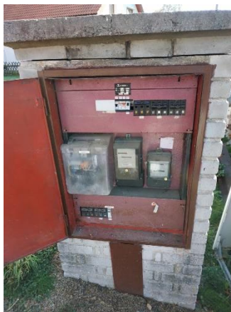
Obr.3 RVO Zhoř – celkový pohled a detail elektroměru
